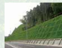
建設(法面工事・造園工事)
