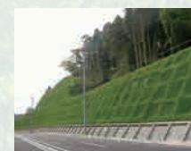
建設(法面工事・造園工事)
