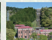
電力(3水力発電所)
