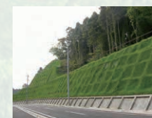
建設(法面工事・造園工事)
